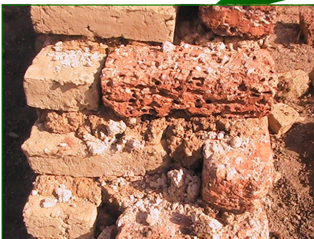
L'alternance de moellons de latérite et de terre.
