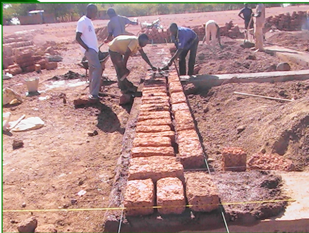
Pose des premiers moellons de latérite.
